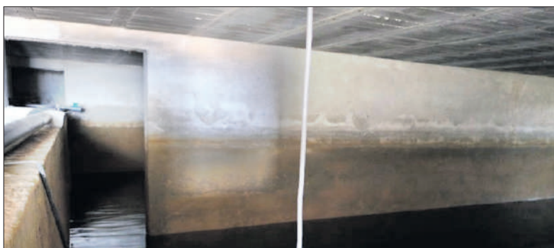
Es necesario confirmar científicamente que la red de tuberías de abastecimiento también cumple la normativa.
