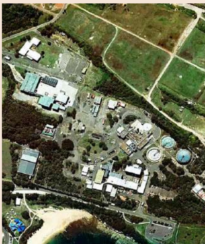
Sistema de tratamiento de agua de Malabar, en Sídney.
